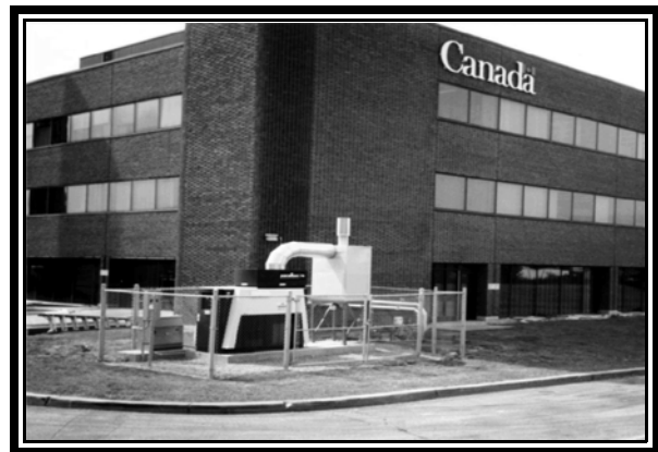
Microturbine fournissant 75 kW d'électricité ainsi que de la chaleur à un bâtiment de Santé Canada à Toronto (photo fournie gracieusement par Mercury Electric Corporation).
