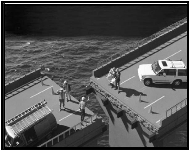
Conséquences de l'utilisation de systèmes de coordonnées incompatibles (photo fournie gracieusement par Zurich North America Inc.).
