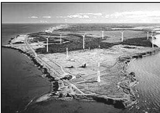
Terrain d'essais éoliens de l'Atlantique, Île-du-Prince-Édouard; la photo a été gracieusement fournie par P.E.I. Energy Corporation.
