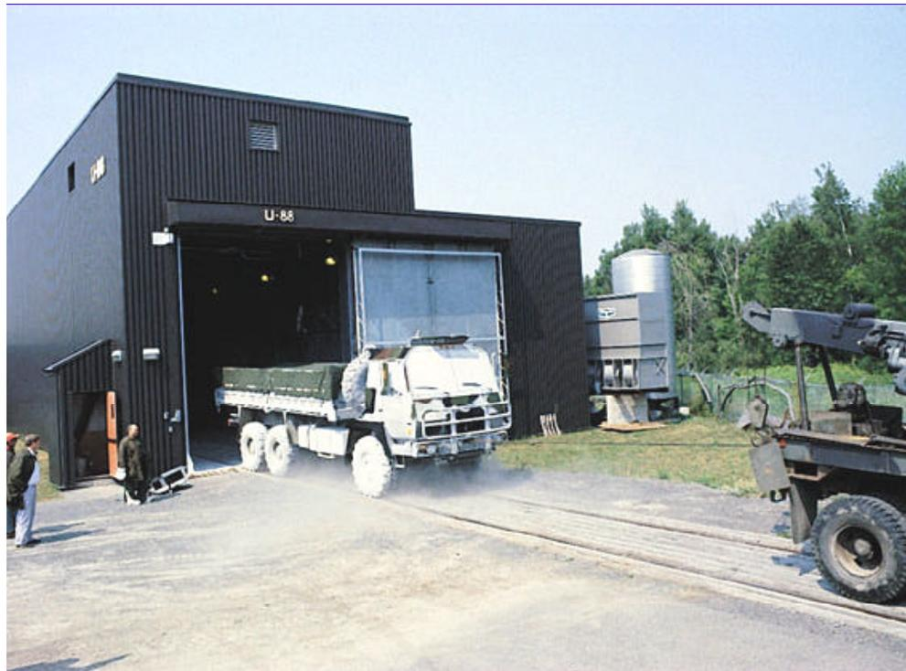
**Cette grande chambre climatique accessible par rail recevoir des véhicules ferroviaires simples les plus longs et les plus lourds ainsi que des véhicules de transport routier, véhicule hors-route, des prototypes et des produits commerciaux.**
