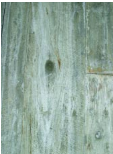
Béton avec coffrage de planche
