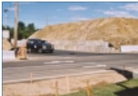
Traverse centrale de la route 117 à l'intersection de la montée Ryan lors de l'étape de la surcharge des coussins (photo prise le 24 juillet 2002).
