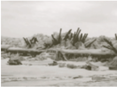
Quai détruit par un amoncellement de glace causé par une onde de tempête dans le sud-est du Nouveau-Brunswick
