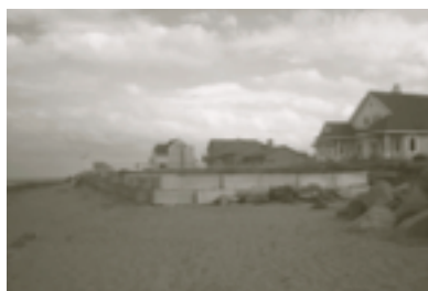
Tentative d'adaptation à la hausse du niveau de la mer par un enrochement de protection
