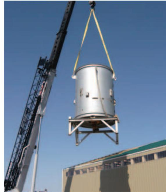
Des travailleurs installent un réacteur thermique, un élément central du processus de craquage thermique de HD-Petroleum.
