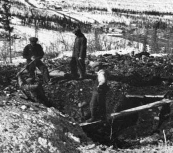
Mineurs creusant le terrain de recouvrement pour qu'on puisse tester le filon souterrain, au-dessus de ce qui allait devenir le site de l'agglomération d'Elsa. Archives du Yukon, coll. Schellinger, n° 5896
