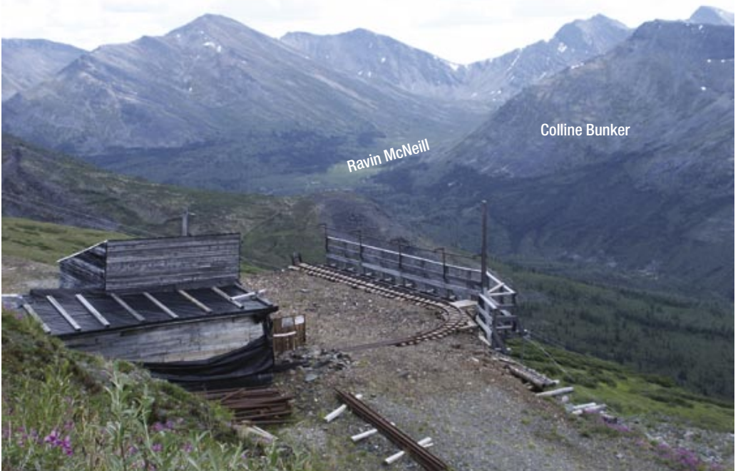
Tête du tunnel accédant au niveau 200 à la mine Keno 700. Peter Long
