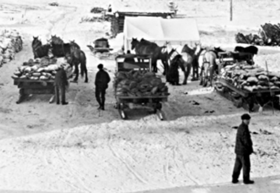
Carrioles remplies de minerai au point de chargement à Keno City, 1922-1923. Archives du Yukon, coll. Schellinger, n° 5830
