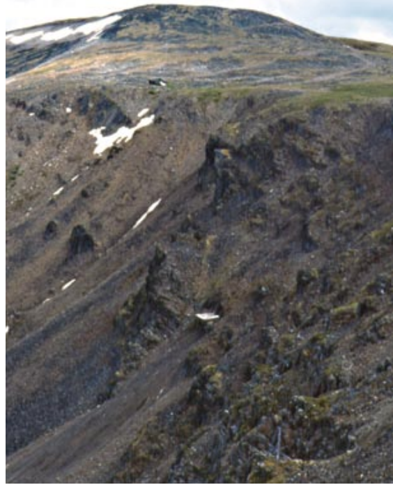
Premiers travaux d'excavation au ravin Faro. L'escarpement et la présence de roches désagrégées rendaient les travaux particulièrement périlleux. Charlie Roots
