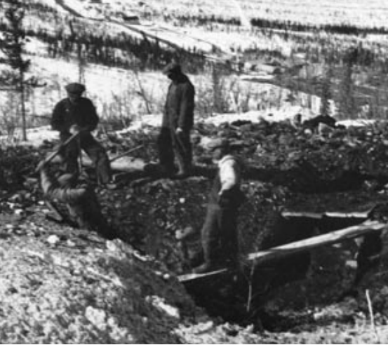
Bergarbeiter graben in der späteren Ortschaft Elsa durch die Bodenauflage, um eine unter Tage liegende Ader zu erreichen. Yukon Archives, Schellinger Coll., #5896
