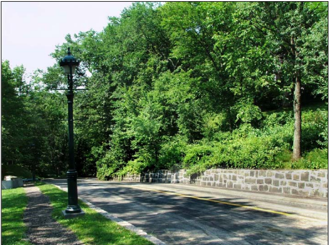
Figure 11 Aperçu de la côte Gilmour dans le segment bordé d'un muret
