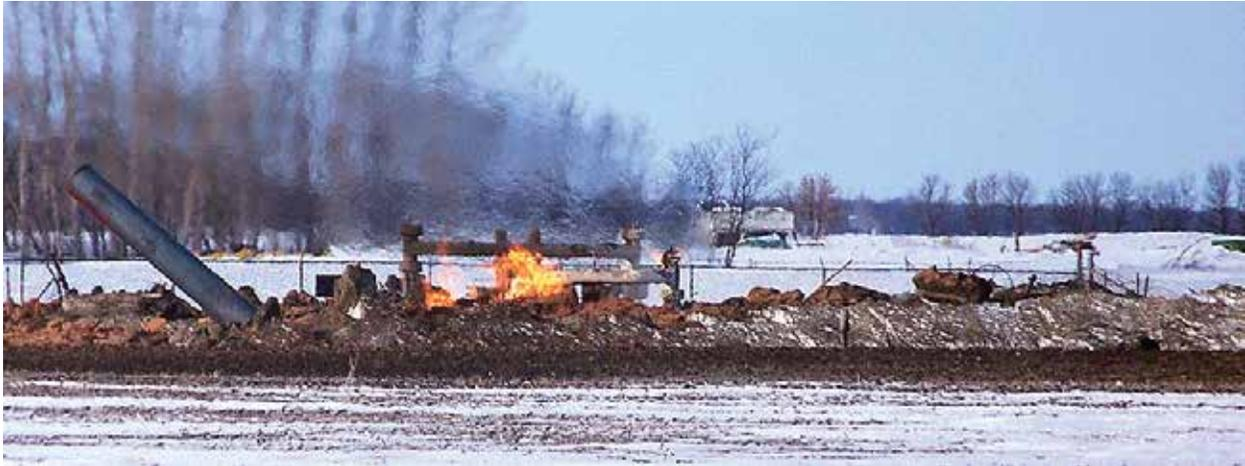
À la suite de l'accident, l'Office national de l'énergie a demandé à TransCanada Pipeline inc. de réaliser plusieurs évaluations techniques le long de la canalisation en cause. TransCanada a effectué de nombreux travaux d'excavation, d'inspection et de réparation le long de la canalisation avant de la remettre en service. Une fois la canalisation remise en service, TransCanada a procédé à des inspections internes afin d'éliminer toute autre menace à l'intégrité du pipeline de gaz naturel.
