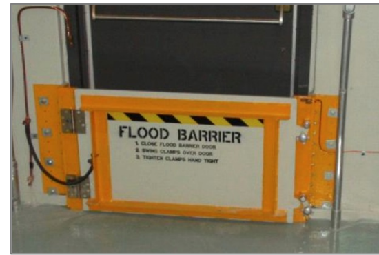
OPG Flood Protection
