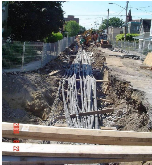
Figure I – Canalisations de télécommunication derrière l'immeuble du CRTC à Gatineau avec supports temporaires pour permettre l'accès à d'autres infrastructures situées en dessous.
