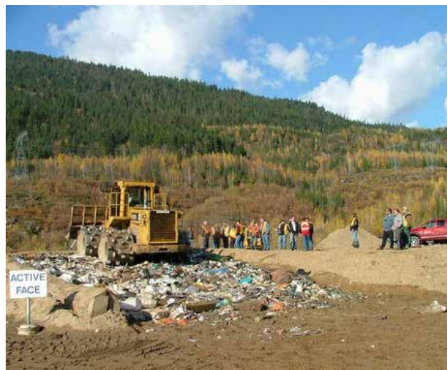
Figure 5-3 : Face active bien définie d'une cellule d'enfouissement
