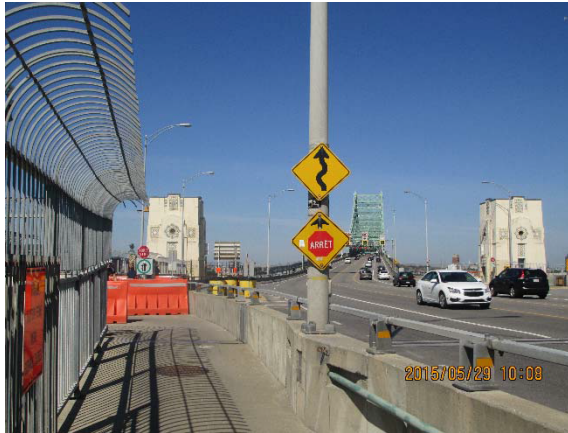
Photo 2.6 : Signalisation en direction nord
