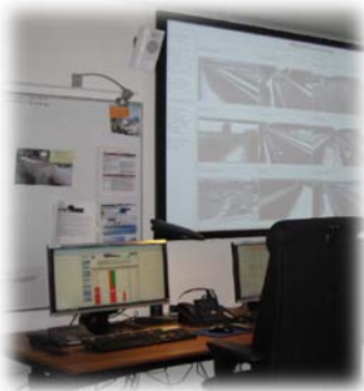
Photo 3.13 : Salle de contrôle
