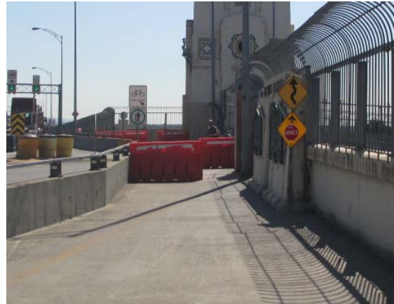
Photo 2.7 : Signalisation en direction sud
