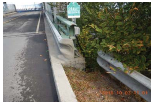
Photographies 2 - côté sud #JC_5_161003_EM_0518
