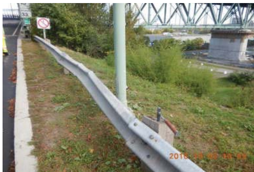
Photographies 1 - côté sud #JC_5_161003_EM_0513
