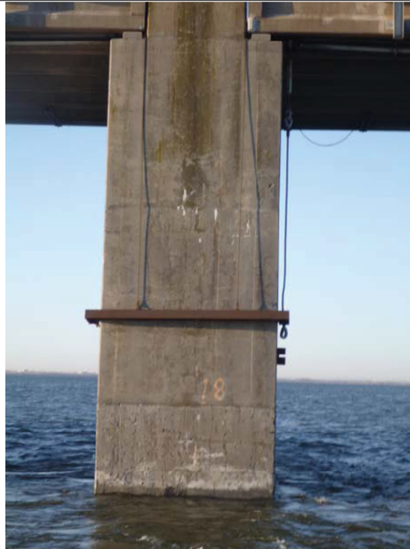
Figure 88 : Paroi aval / Pile 18 (ES18-AV)
