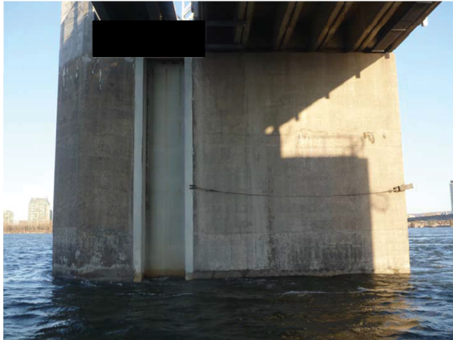
Figure 89 : Paroi droite / Pile 18 (ES18-PD)
