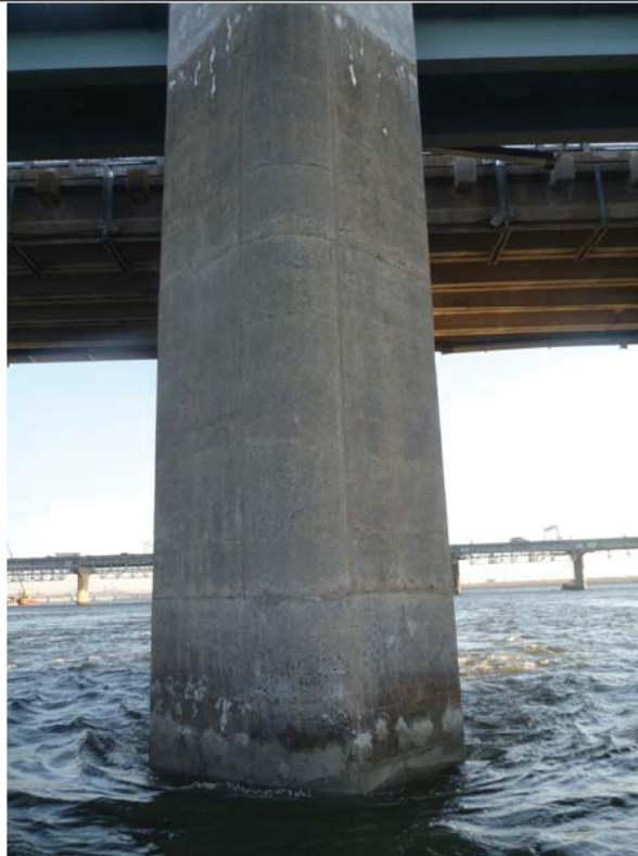
Figure 82 : Paroi amont / Pile 17 (ES17-AM)
