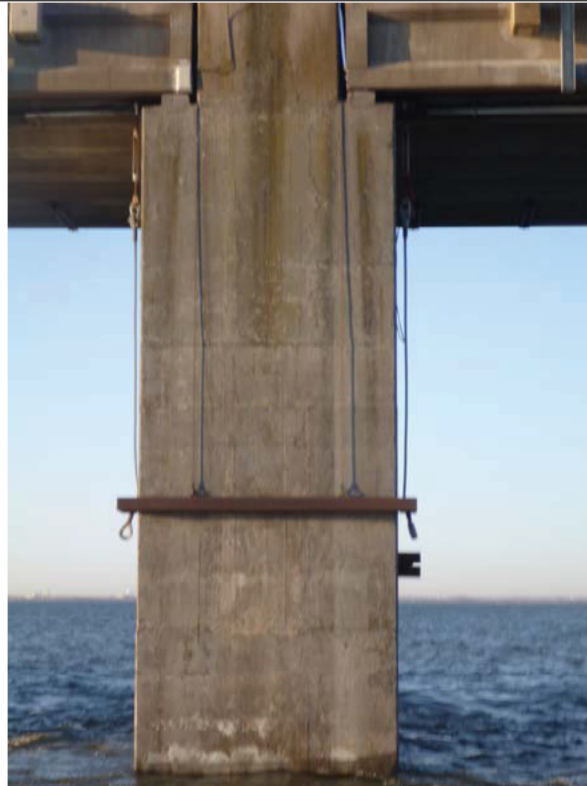
Figure 84 : Paroi aval / Pile 17 (ES17-AV)
