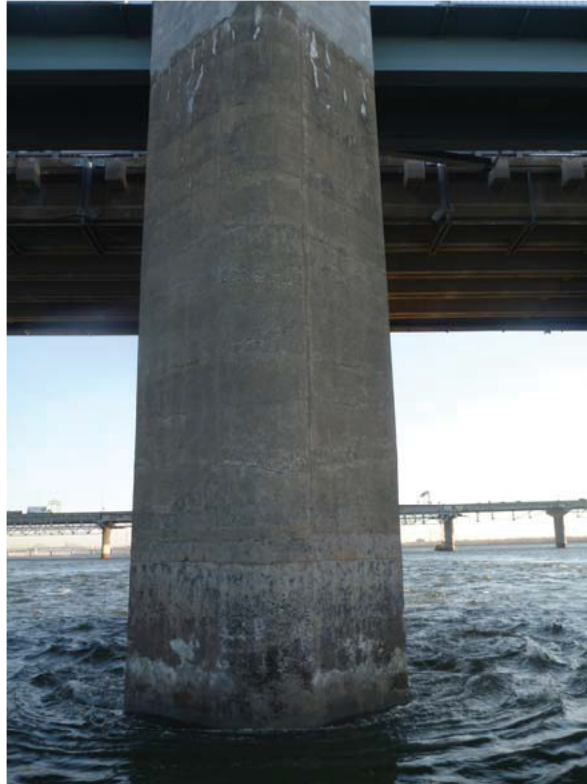
Figure 86 : Paroi amont / Pile 18 (ES18-AM)
