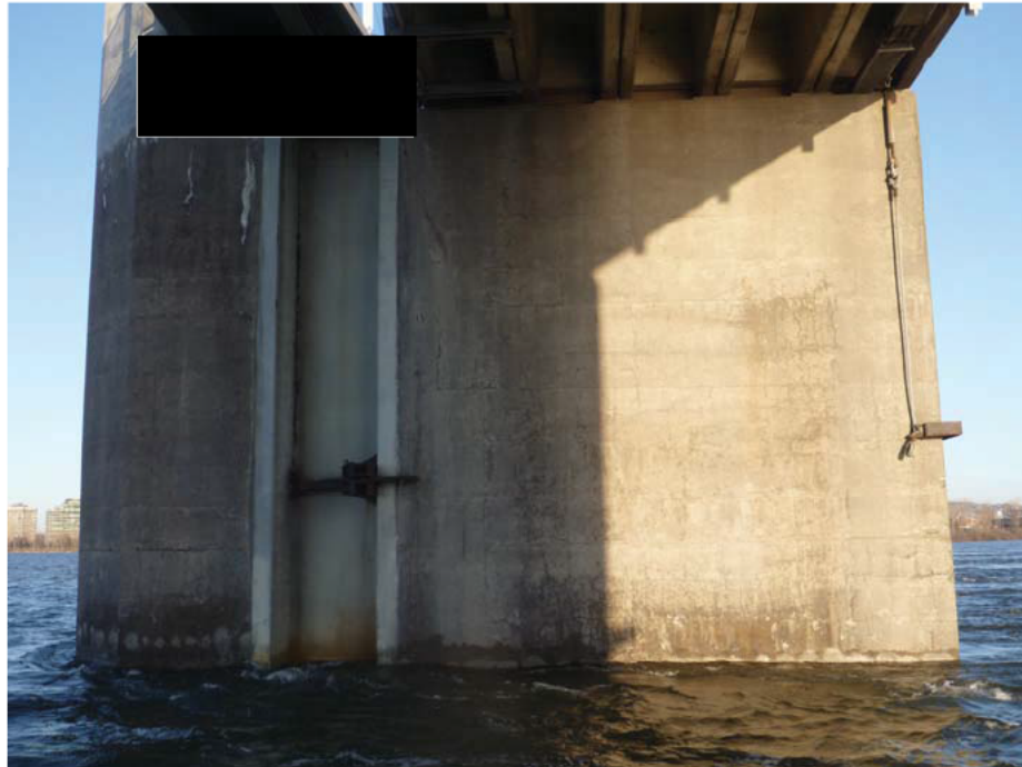
Figure 85 : Paroi droite / Pile 17 (ES17-PD)
